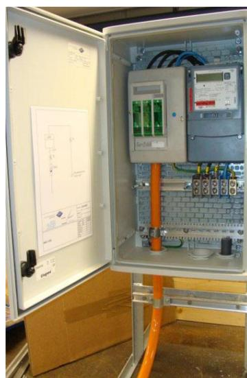
Das Anschlusskabel des Baustromverteilers wird durch eine Kabelverschraubung in den Bauanschlusskasten eingeführt und an den Woerz-Klemmen angeschlossen. Eine Anleitung ist in jedem Bauanschlusskasten beigelegt.
